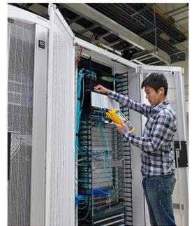
Für den Übergang von OSP-Glasfaser zu Anlagen-Glasfaser im ER ist Fusionsspleißen die am häufigsten angewendete Methode des Anschließens an Glasfaser-Panels mit Duplex-Singlemode-Glasfaserverbindungen für den Anschluss an Geräte des Service-Anbieters. Manchmal gehen eingehende Backbone-Außen/Innen-Glasfasern von nahe gelegenen Gebäuden durch den ER und direkt in den Hauptverteilungsbereich.
